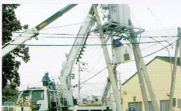
震災により傾いた電柱の復旧作業
